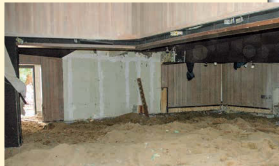
Vor dem Legen neuer Bodenplatten wurde tief ins Erdreich gegraben
